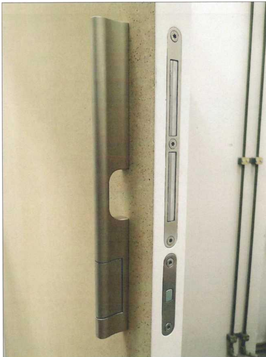
foto. 3 – blok magnetyczny, zamek i uchwyt wewnętrzny – stan zamka WC G 500 – otwarte
