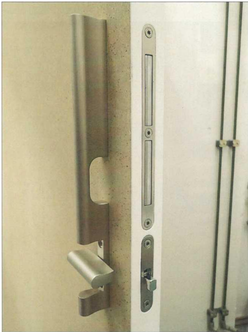
fot. 4 – blok magnetyczny, zamek i uchwyt wewnętrzny – stan zamka WC G 500 – zamknięte
