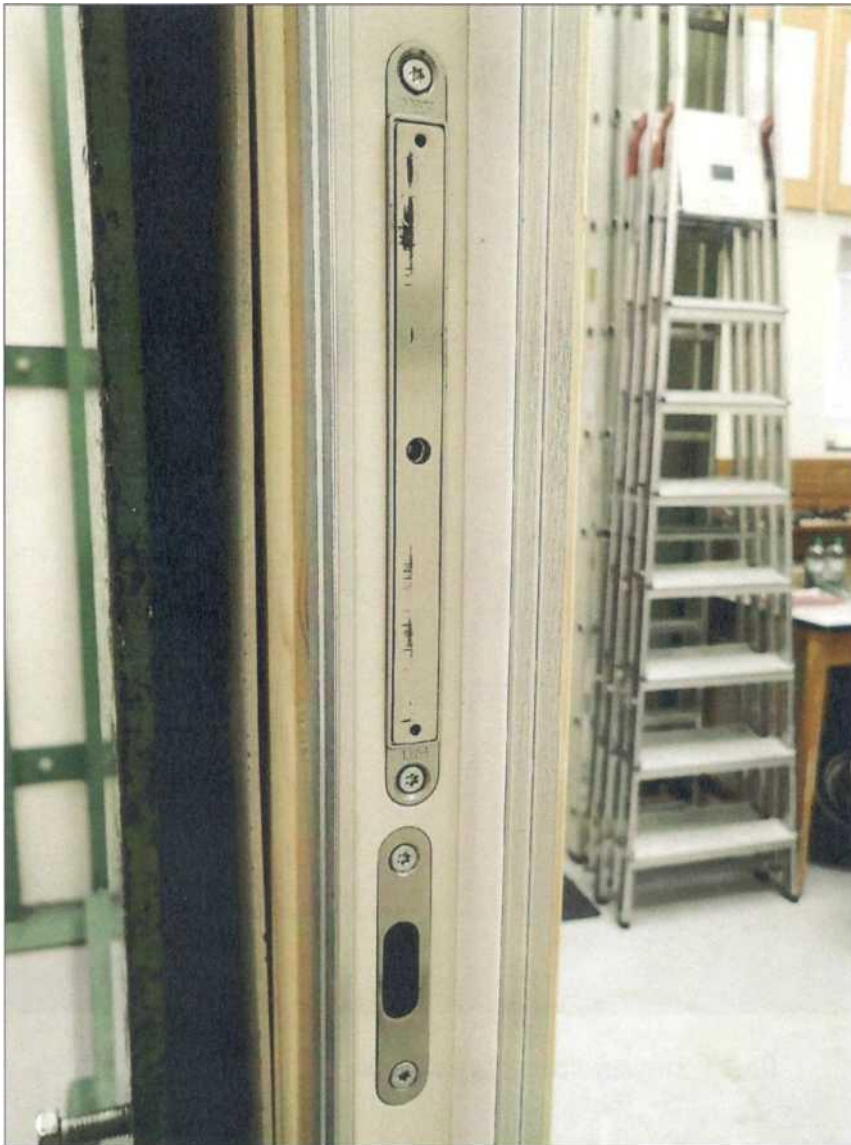
fot. 5 – Magn. i blacha czołowa zamka WC G 500
